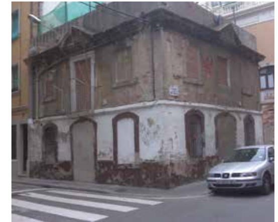
Casa del Porró
