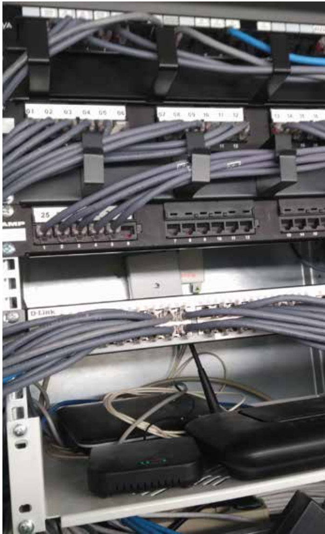
Instal·lació de fibra òptica en equipaments.
