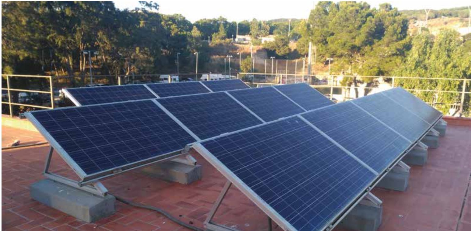
Instal·lació de plaques fotovoltaïques.
