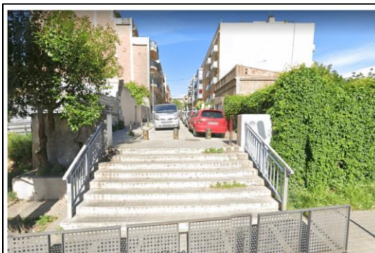
S'inicien les obres de connexió del carrer de la Madriguera amb la Via de Bàrcino
